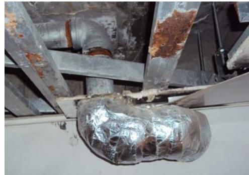
写真2 漏水による発錆等
