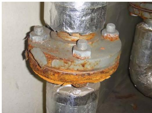
写真3 配管継ぎ手発錆
