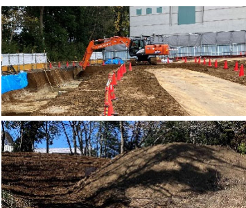
・工事で発生した残土
